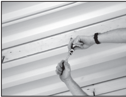
Fig. 11: Installing the hanger bolt.
